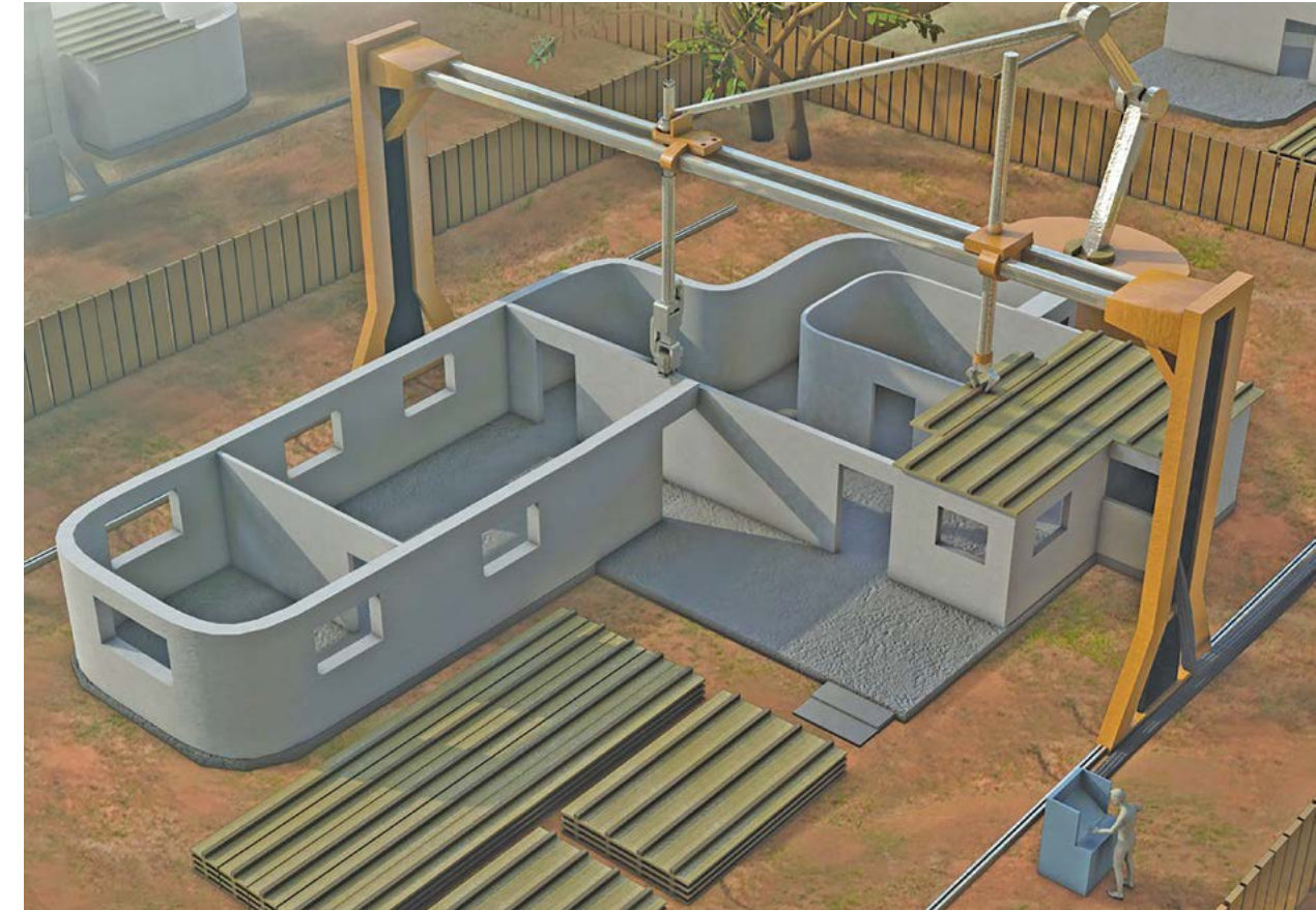
Նկ. 3 Բետոնի 3D-տպագրությունը շինարարությունում
