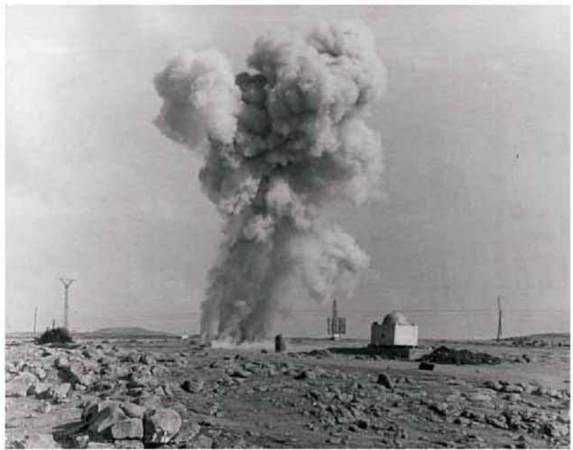
Նկ. 2. Հայկական ատոմակայանի գլխավոր մասնաշենքի մոդելի սեյսմակայունության փորձարկումը
