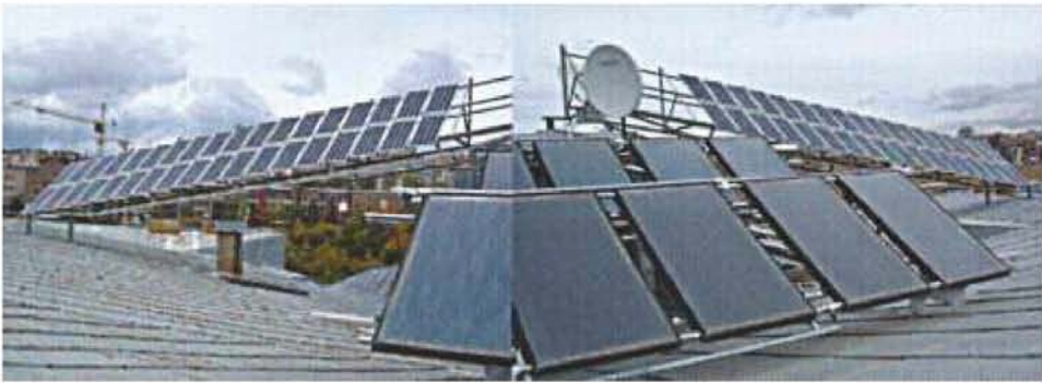
Նկ.1. ՀԱԳ-ի տանիքի ջերմային և 5 կՎտ հզորությամբ ֆոտոէլեկտրական կերպափոխիչների արտաքին տեսքը
