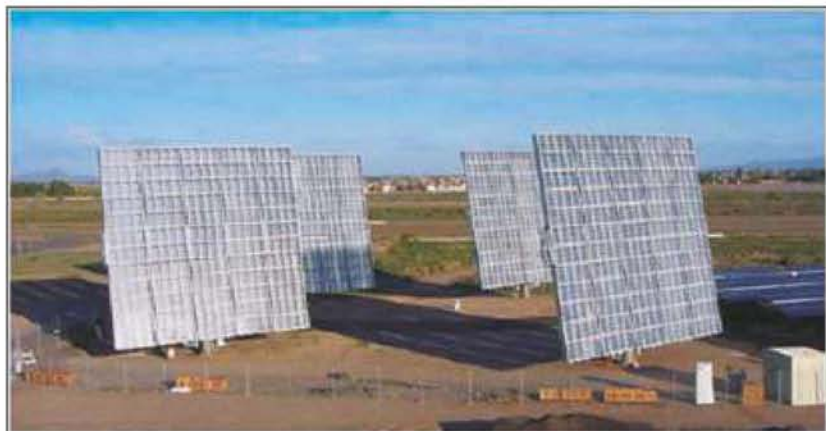
Նկ. 3. ԱՄՆ-ի Amonix կազմակերպության Ֆրենկլային ռաբյայկների կիրառությամբ կետային ֆոկուսացումով 100 կՎտ հզորությամբ ֆոտոէլեկտրական կայան
