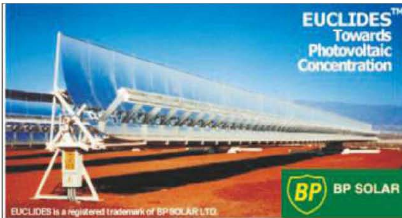
Նկ. 7. Իսպանական EUCLIDES կայանի պարաբոլազանաչային հայելային կոնցենտրատորը
