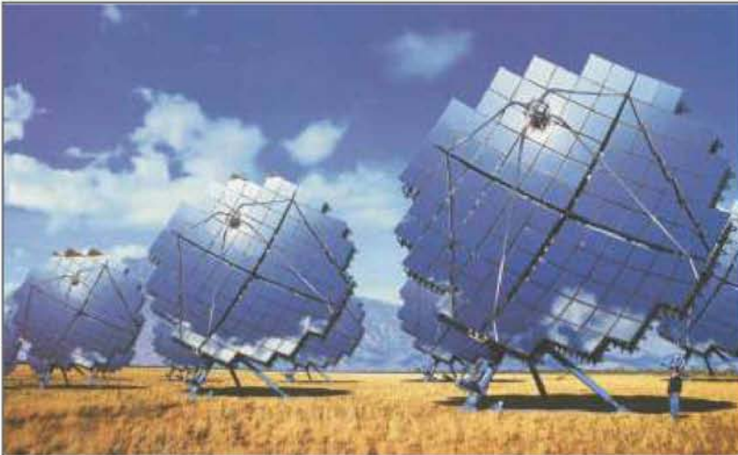
Նկ. 6. Ավստրալական Solar Systems կազմակերպության կողմից մշակված պարաբոլահայելային 280 կՎտ հզորությամբ ֆոտոէլեկտրական կայան
