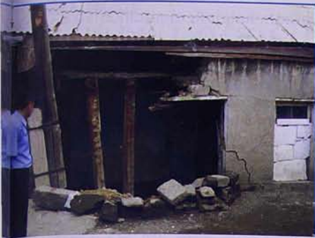
Նկ.5. Քյարիզի փուլզումից վնասված տուն Արցախ թաղամասում (ք. Գյումրի)
